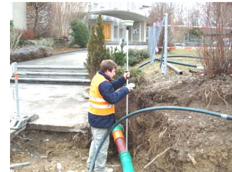
Erfassung von Werkleitungen mit GPS
